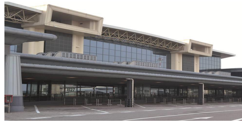
Cliente: S.E.A. S.p.A. Progetto: Realizzazione dei piazzali, viabilità di servizio, ampliamento del terminal, costruzione della Palazzina ENAC - Aeroporto di Milano Malpensa - Terminal 1
