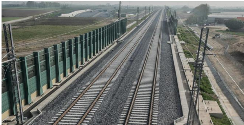
Cliente: CEPAV DUE Progetto: Costruzione della linea ferroviaria ad Alta Velocità, tratto Treviglio-Brescia
