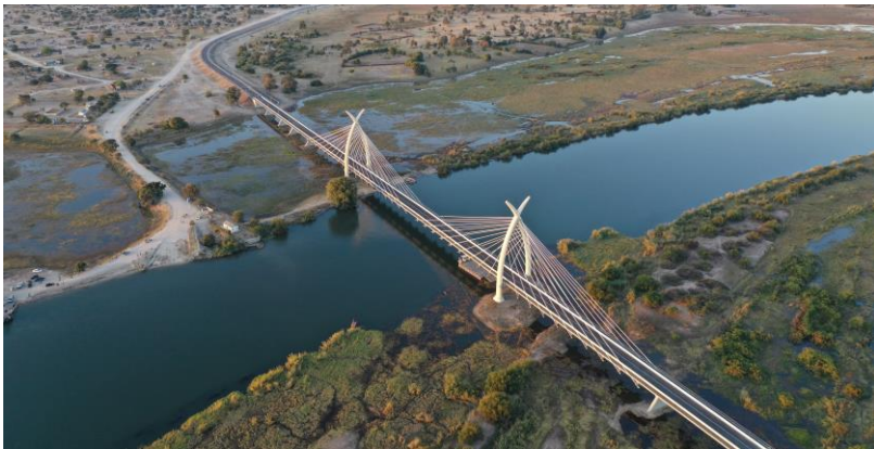
Cliente: Ministry of Transport & Communications - Roads Dept. Progetto: Costruzione del ponte sul fiume Okavango - Botswana
