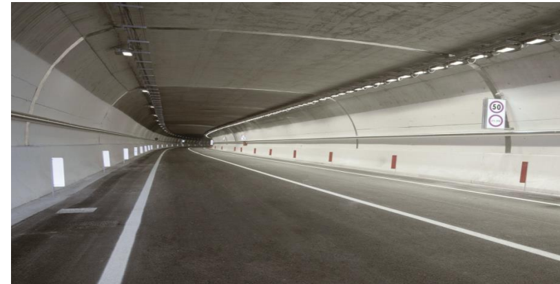
Cliente: Turin Agency 2006 Progetto: Realizzazione della Galleria di Avigliana (tunnel 1.750 m) - Avigliana (Torino)
