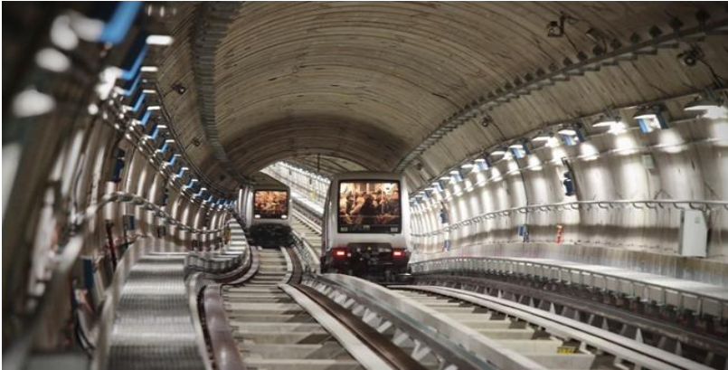
Cliente: Gruppo Torinese Trasporti S.p.A. Progetto: Costruzione della Metropolitana Automatica di Torino Lotti 3 e 5 - tratta Collegno-Porta Nuova (tunnel 5.300 m)
