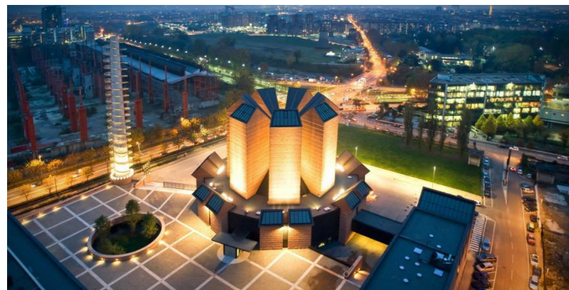
Cliente: Chiesa del Santo Volto Progetto: Costruzione della Chiesa del Santo Volto - Torino
