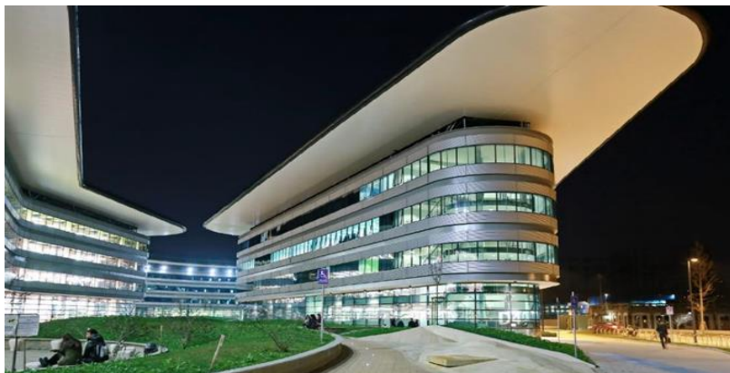
Cliente: Università di Torino Progetto: Costruzione del Nuovo Campus Einaudi - Dipartimento di Giurisprudenza e Scienze Politiche - Torino
