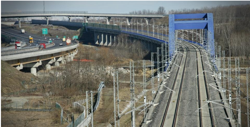
Cliente: C.A.V. TO-MI Progetto: Costruzione della Linea ferroviaria ad Alta Velocità To-Mi- tratta Brandizzo-Agognate-Biandrate
