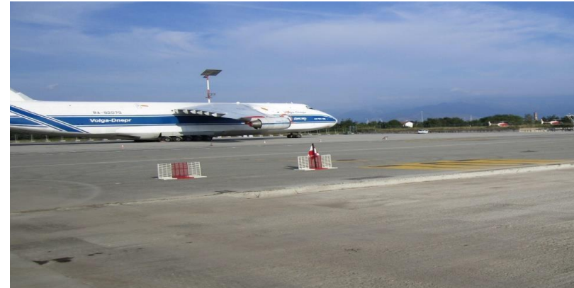
Cliente: SAGAT S.p.A. Progetto: Realizzazione pista di rullaggio - Aeroporto di Torino Caselle
