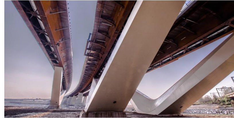
Cliente: C.A.L. Progetto: Costruzione della Tangenziale Est Esterna di Milano
