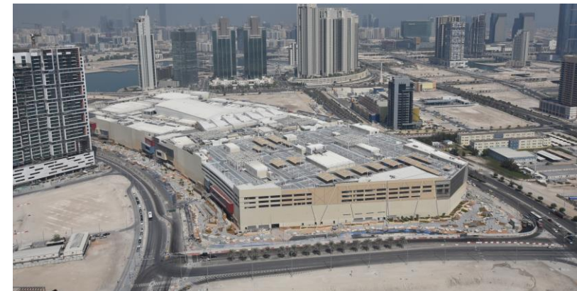
Cliente: AL FARWANIYA PROPERTY Progetto: Costruzione del Centro Commerciale Reem Mall – Abu Dhabi, EAU
