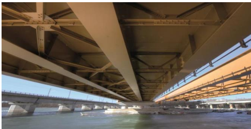
Cliente: S.A.T.A.P. S.p.A. Progetto: Viadotto Bernate - A4
