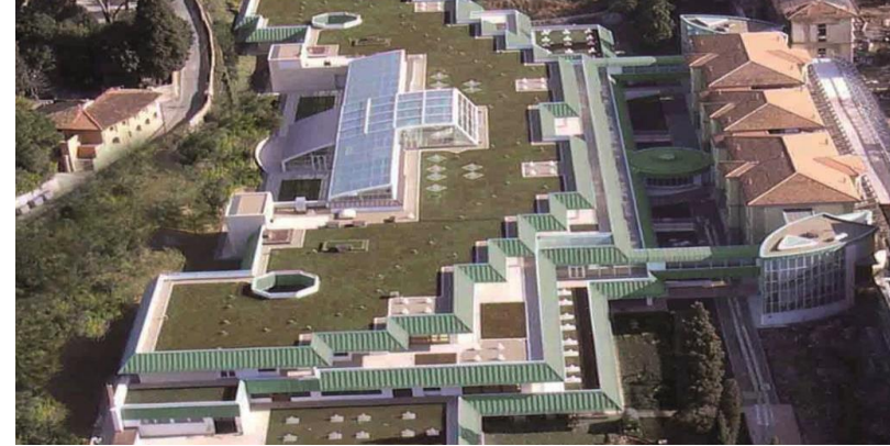
Cliente: Azienda Ospedaliera Mayer Progetto: Realizzazione del Nuovo Ospedale Pediatrico A. Mayer - Villa Ognissanti - Careggi - Firenze
